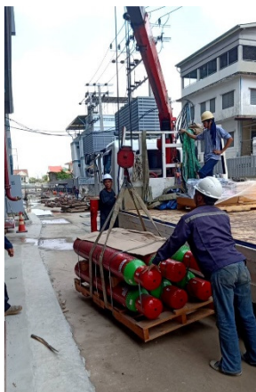
ภาพที่ 22 การลำเลียงวัสดุก่อสร้างขนาดใหญ่โดยใช้เครนยก
